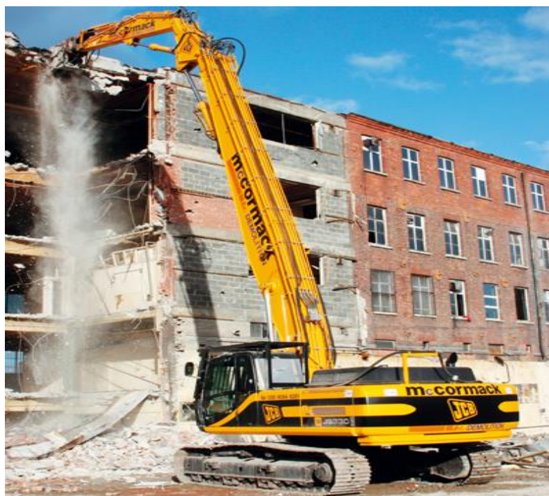
Рисунок 1 – Снос аварийного кирпичного здания
