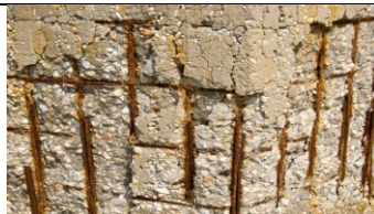
Рис. 3 - Отслоение защитного слоя бетона, оголение и коррозия арматуры железобетонной стенки
