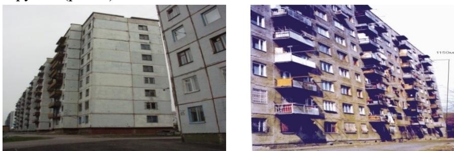
**Рис. 1. Примеры кренов зданий от неравномерных осадок и оползневых процессов**
