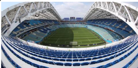
Рис. 5. Мембранно-стержневое покрытие стадиона Фишт в Сочи
