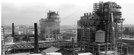
Рис. 4. Цеха из металлических конструкций нефтеперерабатывающих заводов
