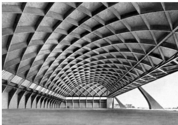
Рис. 1. П.Л. Нерви. Авиационный ангар в Орбетелло, 1938. Развитые высокие и одновременно узкие ребра жесткости из железобетона придают своду ангара прочность [7]
