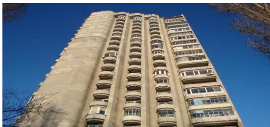
Рис 1. Жилой дом из шлакощелочного бетона г. Липецк Fig 1. Residential building from slag-alkaline concrete Lipetsk
