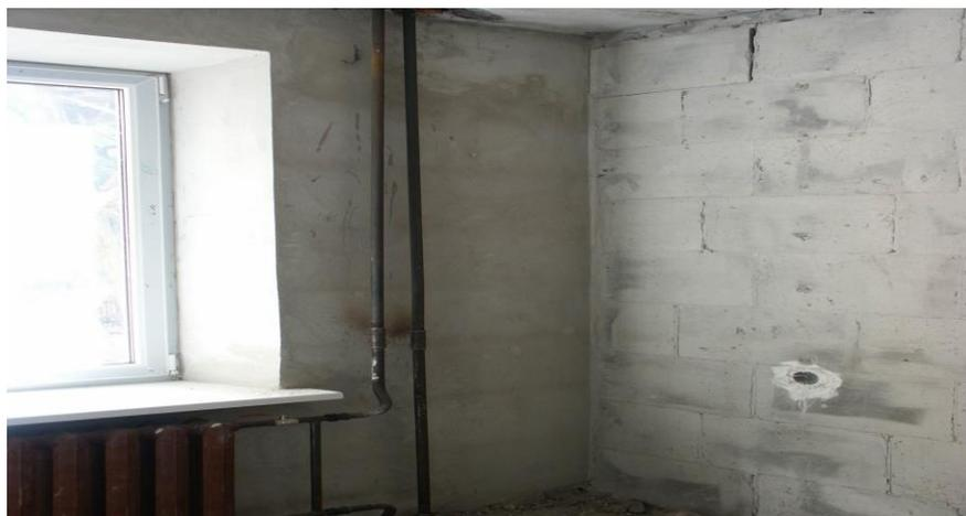
**Рис. 2. Вид кладки из фибропенобетонных блоков до начала отделочных работ**
