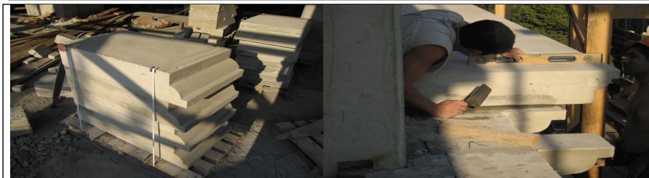
а) фибропеножелезобетонные карнизы заводского изготовления
