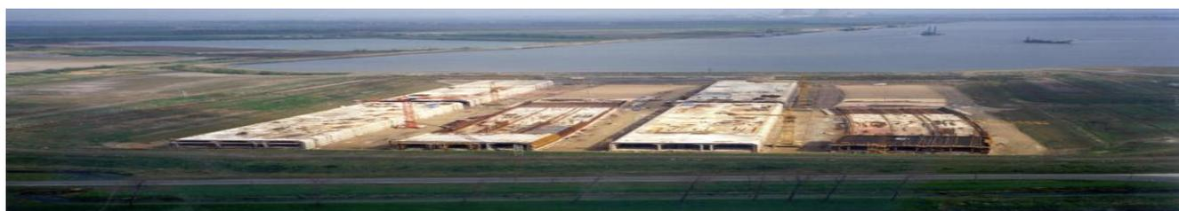
**Рис. 6. Сооружение секции тоннелей в специальном котловане (Нидерланды)**
