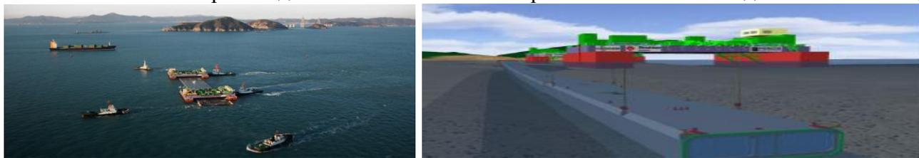
**Рис. 9. Погружение секций со специальной баржи и пример поперечного сечения тоннеля с указанием обратной засыпки**
