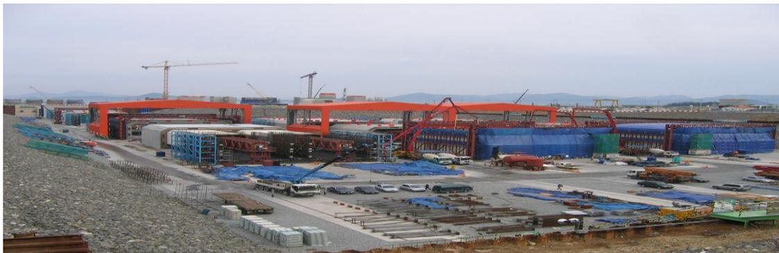
**Рис.7. Вид площадки для одновременной отливки нескольких секций тоннеля (западный берег залива Jinhae)**
