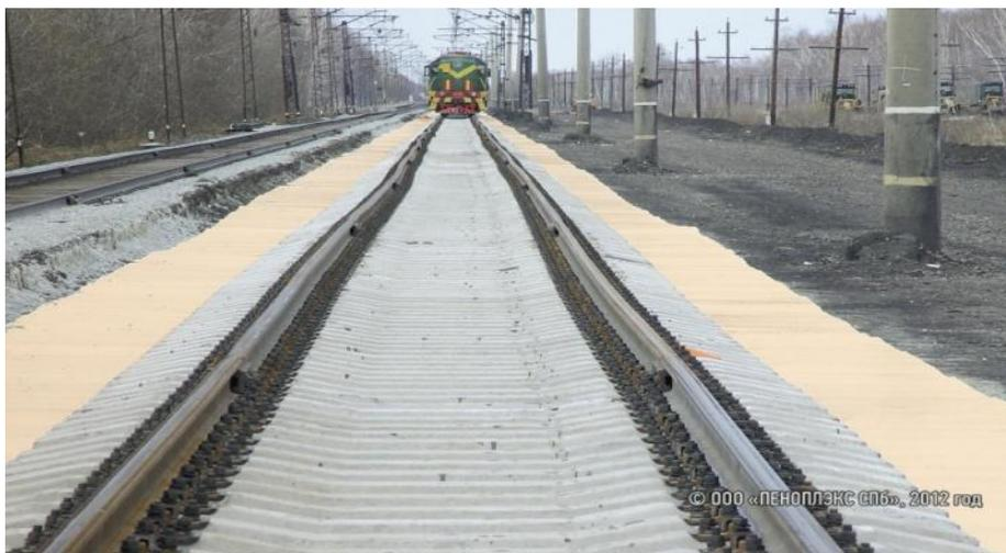
**Рисунок 1-** Укладка плит марки «Пеноплекс – 45»
