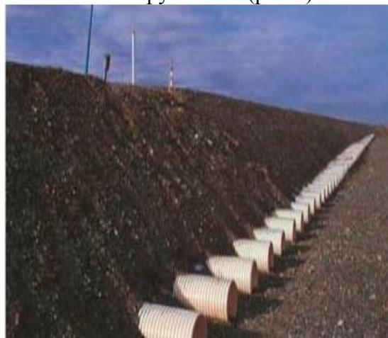
**Рисунок 2-** Поперечные вентилируемые трубы в основании земляного полотна
