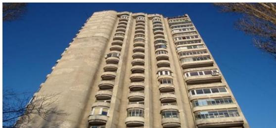
**Рис 1. Жилой дом из шлакощелочного бетона г. Липецк**
