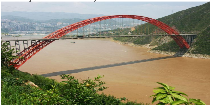
Рис. 1. Трубобетонный арочный мост Чунцин Ушань через реку Янцзы [2]
