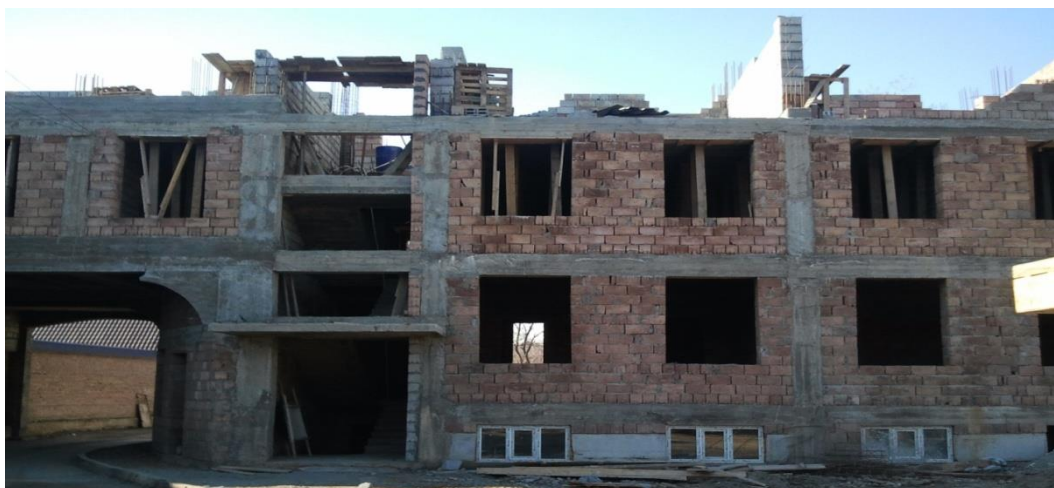
Рисунок 4 – Строительство общественного здания в г. Хасавюрт предприятием ООО «Мустанг» с использованием керамобетонных мелкоштучных стеновых блоков
