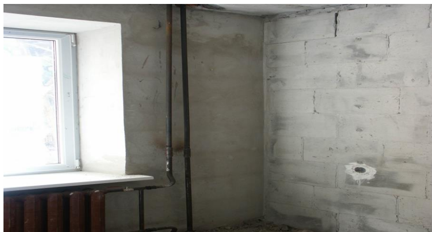
Рис. 2. Вид кладки из фибропенобетонных блоков до начала отделочных работ Fig. 2. Type of masonry from fiber-reinforced concrete blocks before the start of finishing work
