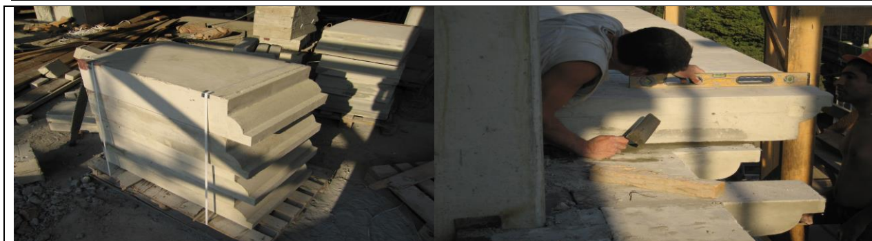
а) фибропеножелезобетонные карнизы заводского изготовления
