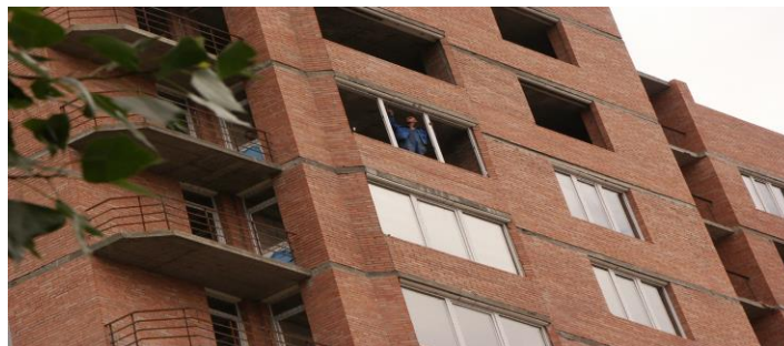
Рис. 3. Крепление фибропенобетонных галтелей к перекрытиям, выходящим на фасад зданий
