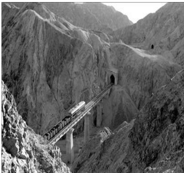
Рисунок 4 - Самый высокогорный в тоннель
