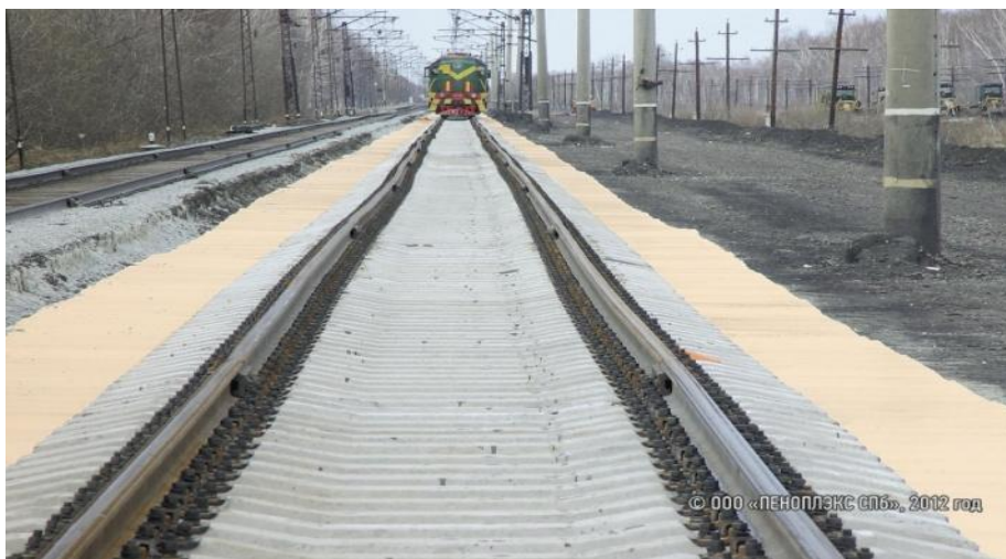
Рисунок 1- Укладка плит марки «Пеноплекс – 45»
