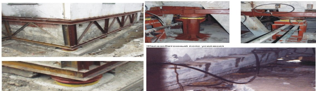
Рис. 2. Варианты усиления и домкратных узлов
