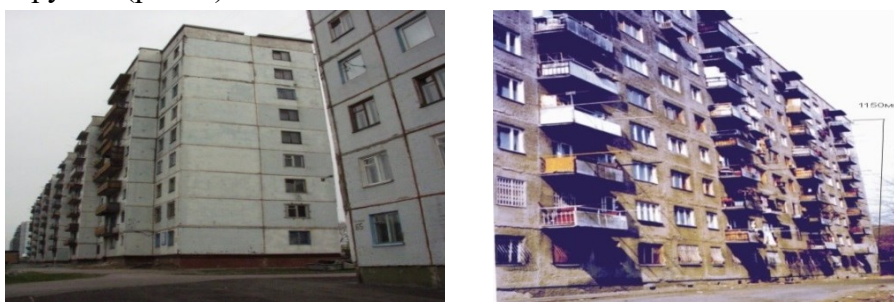
Рис. 1. Примеры кренов зданий от неравномерных осадок и оползневых процессов Fig. 1. Examples of building tilts due to uneven settlement and landslide processes
