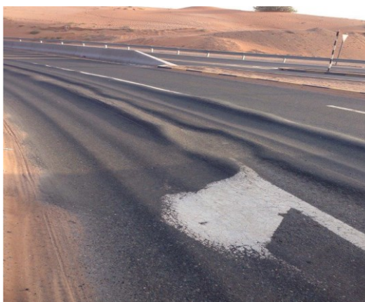
Рис. 1. Колейность на покрытии автомобильных дорог в ОАЭ [24]
