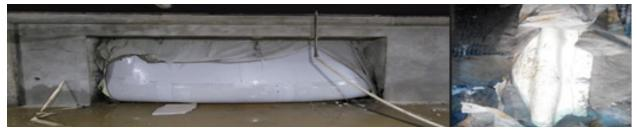
Рис. 2. a) Защитный экран из мембраны ECOBASE™V-UV, выдерживающий давление напорной воды в зоне подземных конструкций; б) мембранаLOGICBASE™V-SL, выдерживающая отрицательное давление воды в зоне деформационного шва
