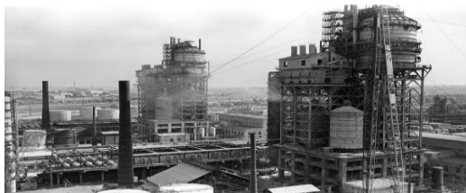
Рис. 4. Цеха из металлических конструкций нефтеперерабатывающих заводов
