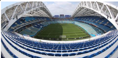
Рис. 5. Мембранно-стержневое покрытие стадиона Фишт в Сочи
